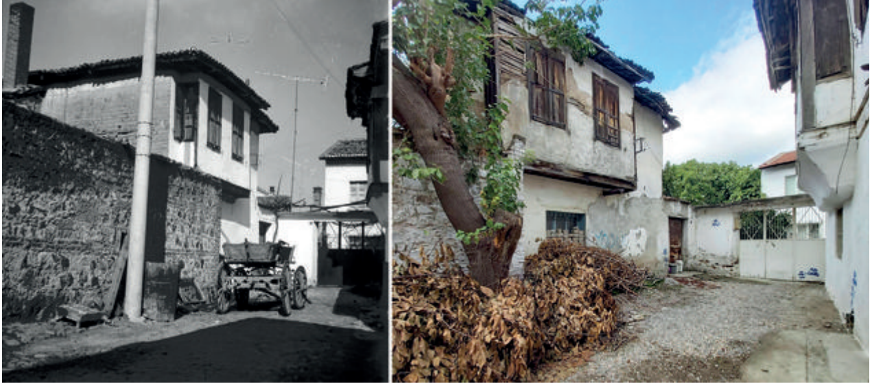
Şekil 33: 37 Ada 24 Parseldeki tescilli yapının 1973 yılındaki ve 2019 yılındaki görüntüsü (MSGSÜ-RADA).
