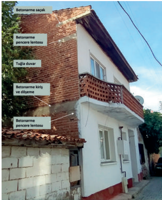
Şekil 34: 78 Ada 3 Parsel Dış ve iç duvarları tuğla, lento ve döşemesi betonarme konutlar.
