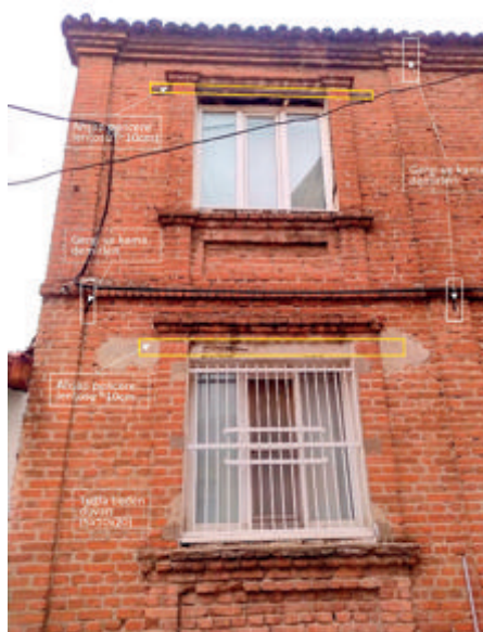
Şekil 31: 36 Ada 26 parsel, dış duvarları kâğır, iç duvarlar ve döşemesi ahşap, lentoları ahşap, kâğır duvarları demir gergili sistem.
