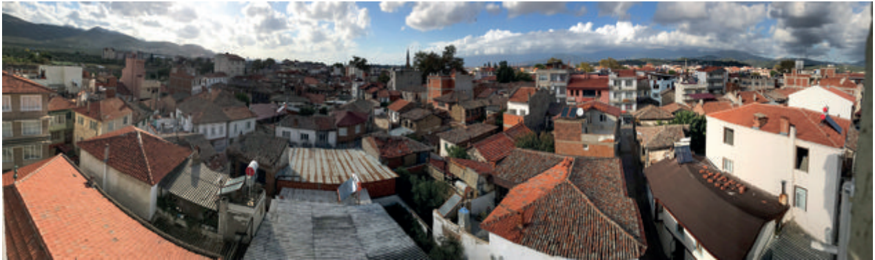
Şekil 9: Mescid Camisi minaresinden Havran Kentsel Sit Alanı görünüşü (MSGSÜ-RADA, 2019).
