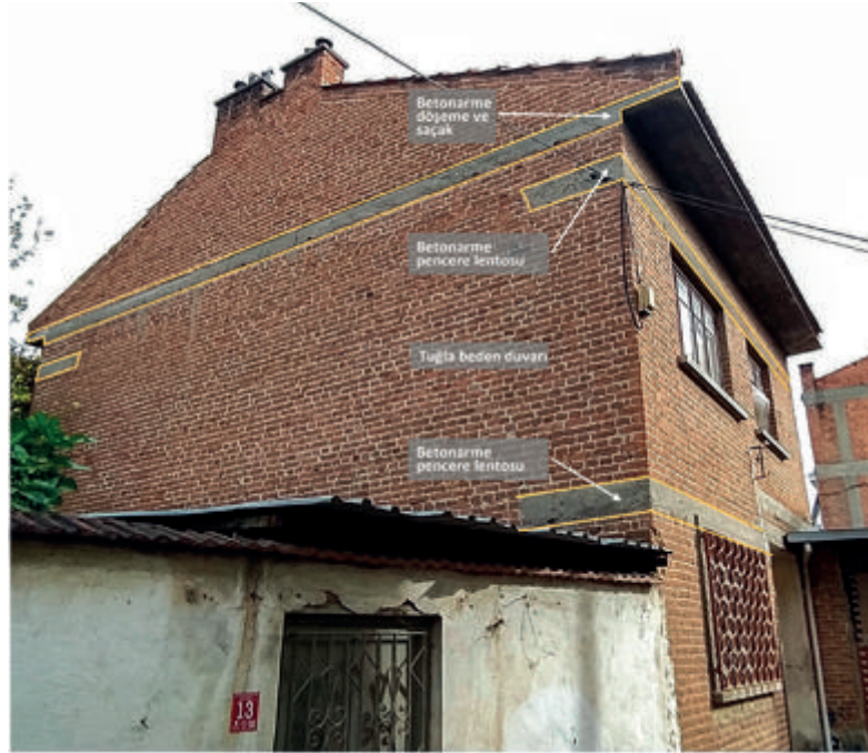
Şekil 33: 59 Ada 21 Parsel, Dış duvarları ve iç duvarları tuğla, lentosu betonarme ve döşemesi ahşap konutlar.
