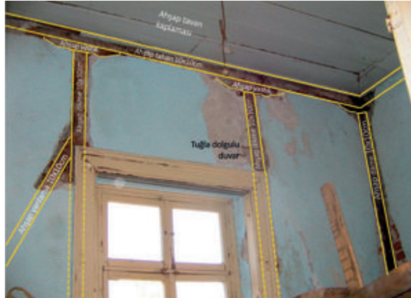
Şekil 27: 74 ada 23 Parsel, dış duvarları karma (tuğla+ahşap karkas arası dolgu), iç duvarları ahşap karkas ve döşemesi ahşap.
