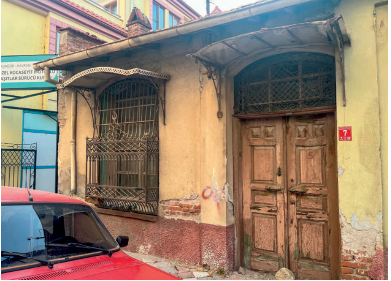
Şekil 26: 204 Ada 20 Parselde 20. yüzyıl ortası demir işçiliği örneği (MSGÜ-RADA).
