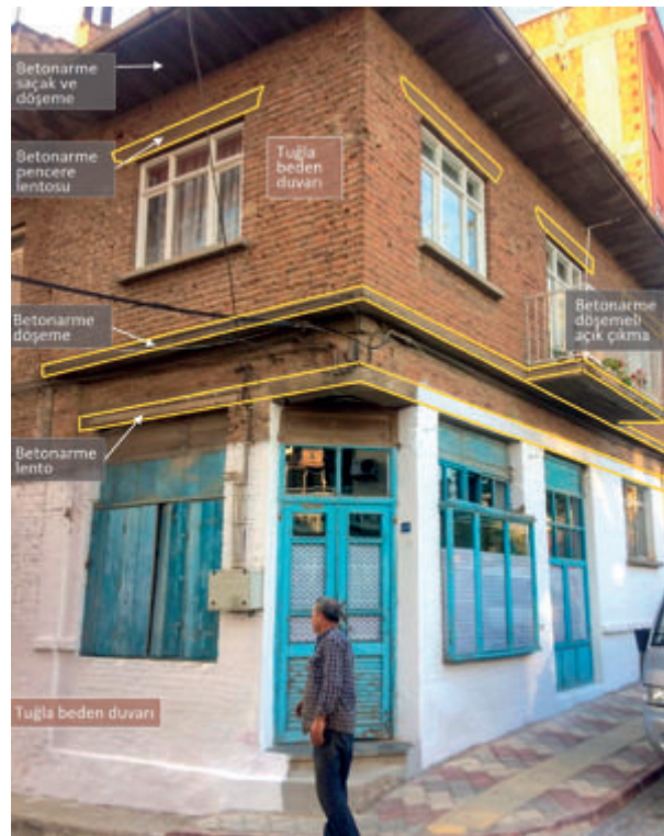
Şekil 34: 78 Ada 3 Parsel Dış ve iç duvarları tuğla, lento ve döşemesi betonarme konutlar.
