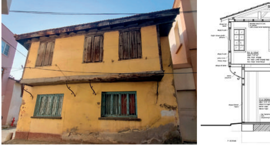
Şekil 2: 205 ada 15 parseldeki yapının cephesi (2023) ve sistem kesiti.
